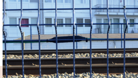
Gros plan sur un des capteurs disposés tous les 2,5 m détectant le moindre choc
