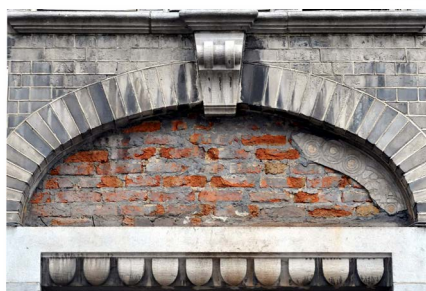
Propriété Lambin-Van Bergen Rue de Dave n°s 92 à 96, 1908-1909. Décollement progressif des sgraffites de l'immeuble d'angle.
