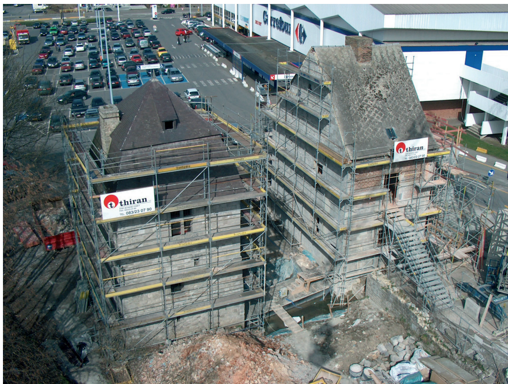
Fig. 6 La tour et le logis d'Anhaive sous les échafaudages, vus depuis la grue du chantier (2004)
