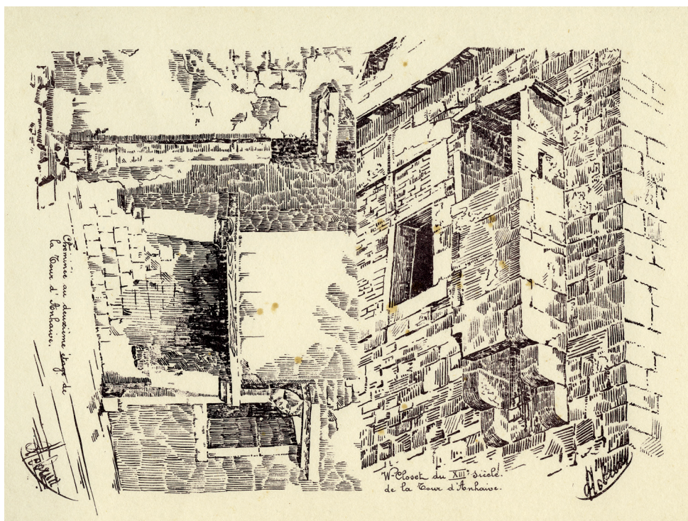
Fig. 6 Cheminée et latrines du second étage de la tour. État vers 1914 Dessins de L. Lebrun.
