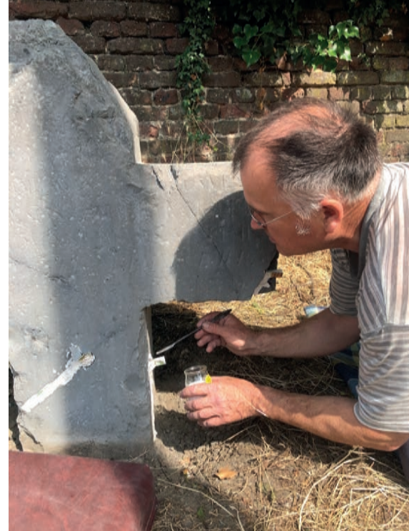
Application de la colle époxyde via un entonnoir
