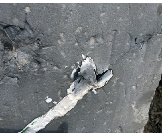
Colmatage des fissures de la pierre au plâtre
